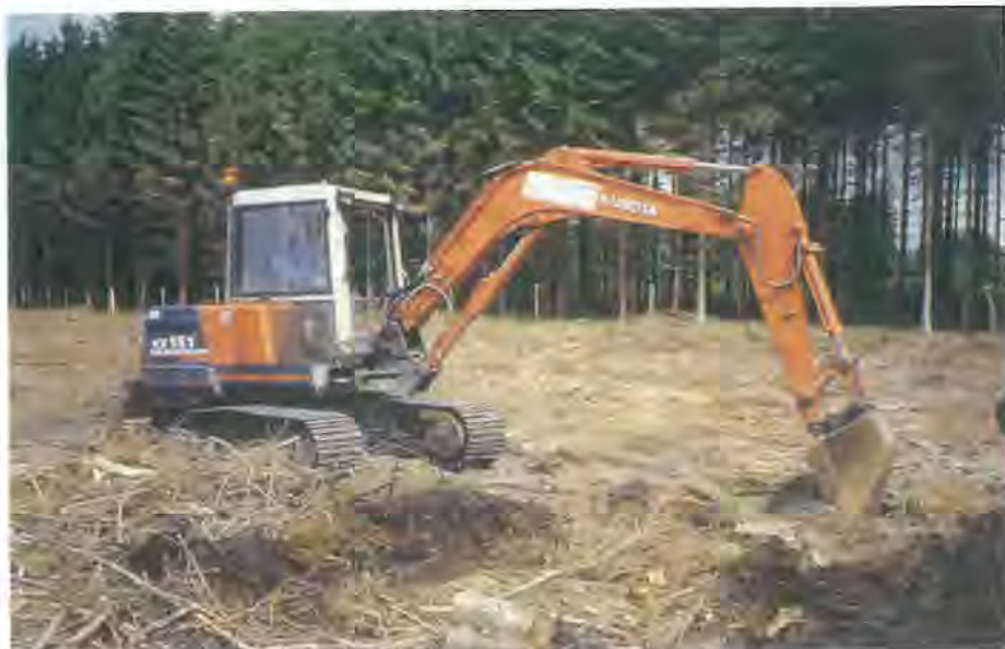
Figur 7. Punktvise dyb omgravning ("reolgravning") med gravemaskine. (Foto: Frans Theilby).
